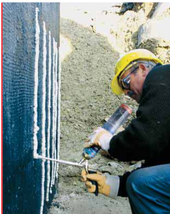
Nakładanie pasków kleju INSTA-STIK™ PM bezpośrednio na ścianę fundamentu.
