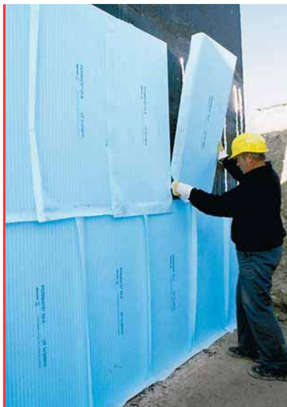
Montaż płyt izolacyjno-drenażowych PERIMATE™ DI-A firmy Dow
