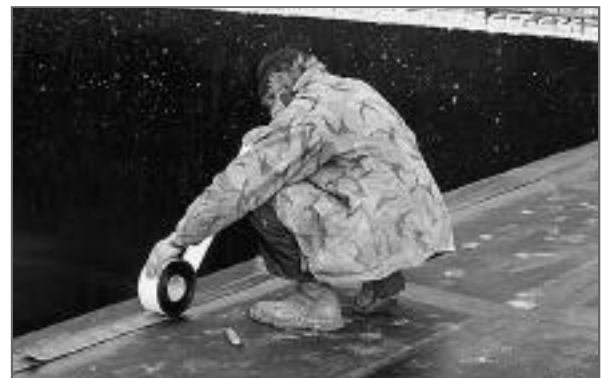
Gruntowanie złącz pomiędzy płytami i układanie Armour Tape
