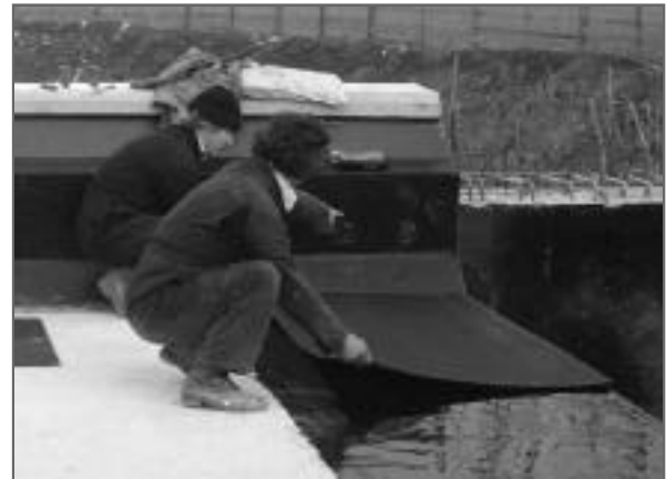
Płyty Servipak umieszczane na miejscu
