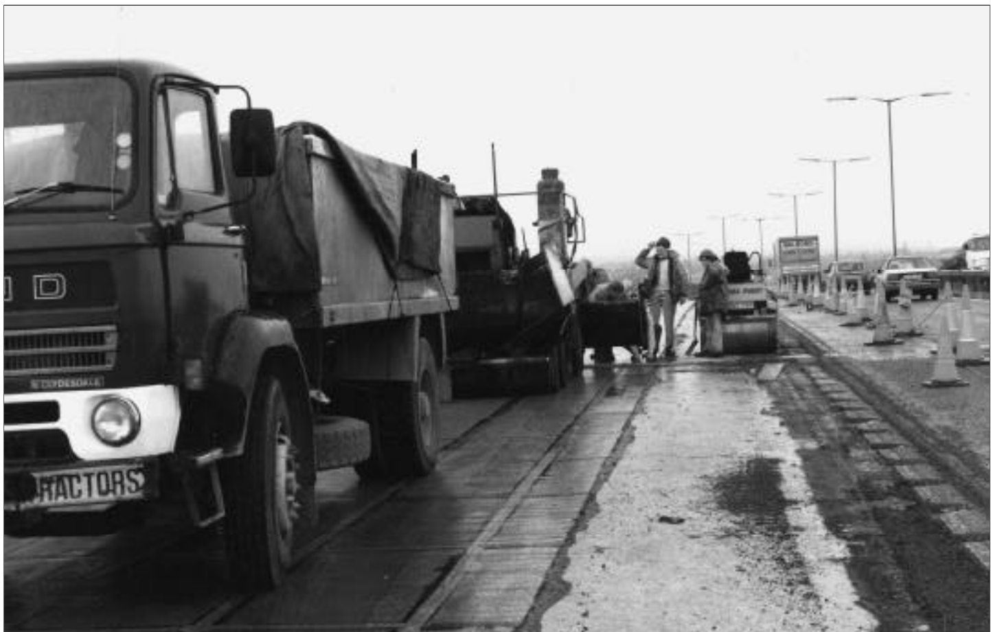
Układanie asfaltu na Servidek/Servipak
