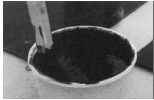
Dwuskładnikowy Servidek mieszany drewnianą łopatką
