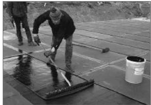
Układanie Servidek za pomocą zacieraczki z taśmą gumową
